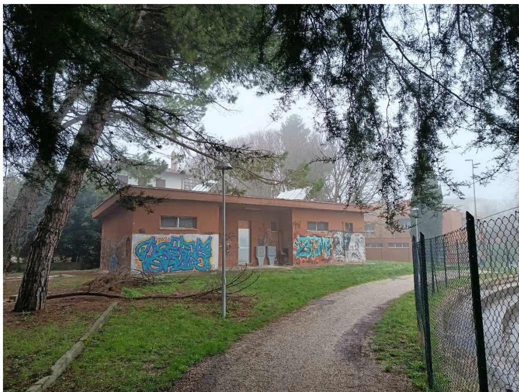
Vista esterna dell'edificio
