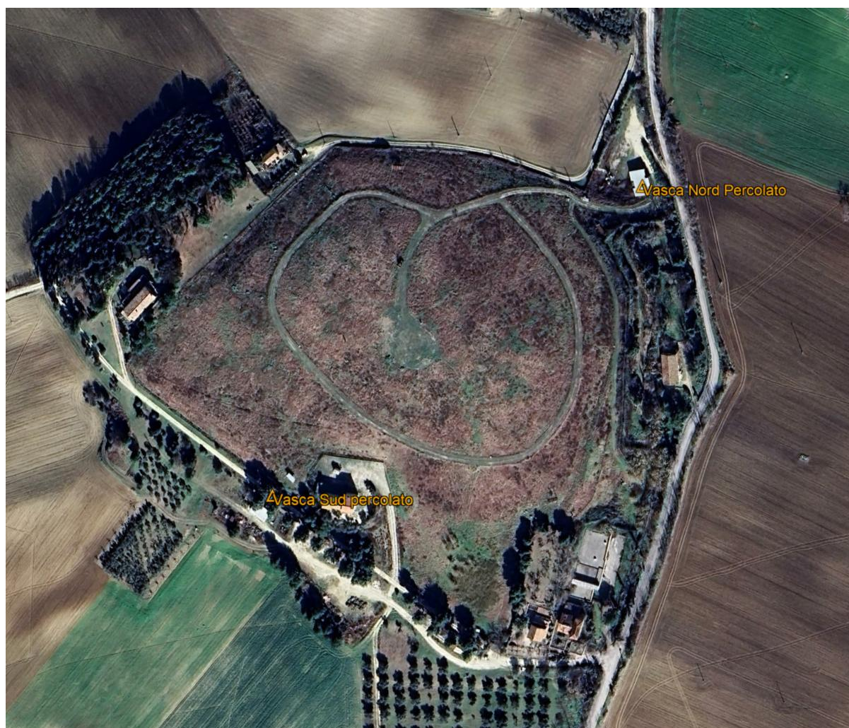
Figura 2-3: ubicazione delle vasche di raccolta del percolato dove si effettua il campionamento
