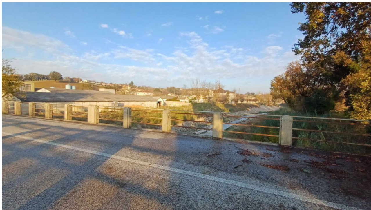
Foto 3 - Veduta ponte dalla sponda dx verso valle con parziale inquadratura sul Fiume Nevola
