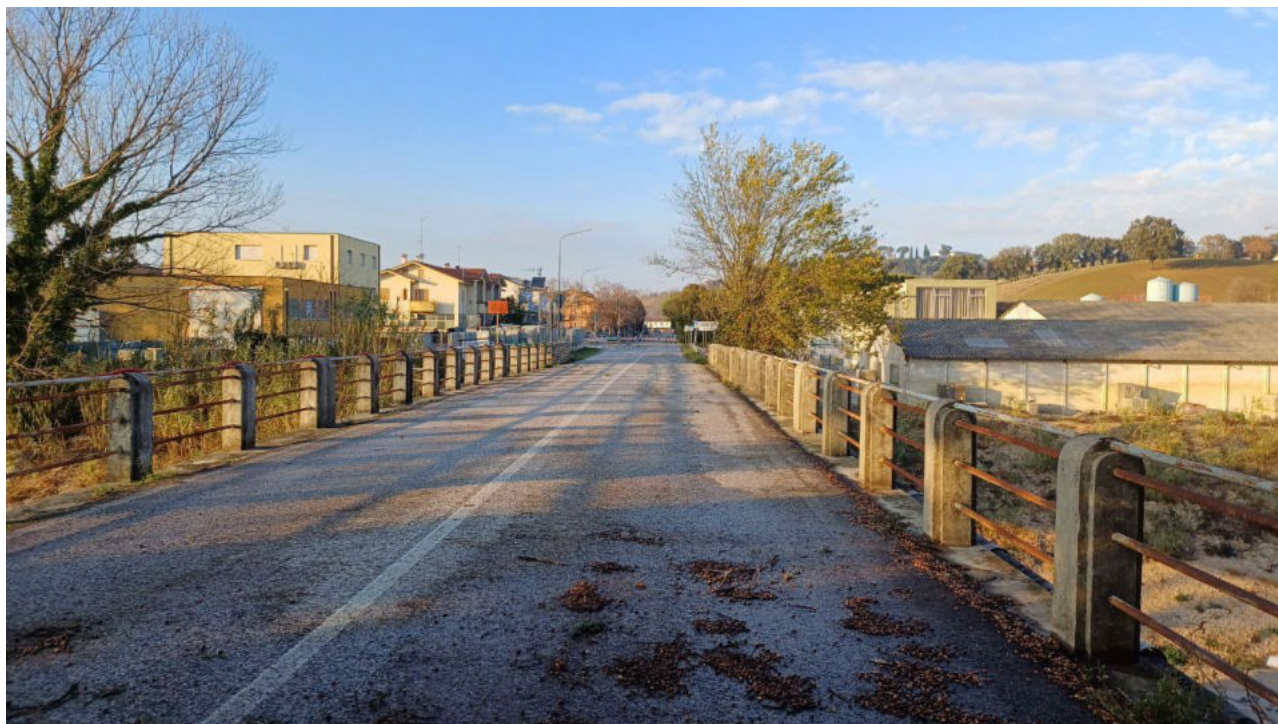
Foto 1 - Veduta ponte dalla sponda dx verso la sx
